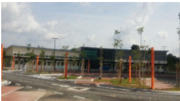
Blok Pemulihan Vokasional / Vocational Rehabilitation Block
